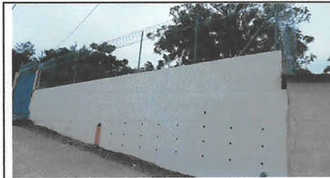
Foto 6: Pared a orilla de la calle entrada principal
