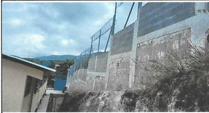
Foto 2: Pared, malla y Razer instalado
