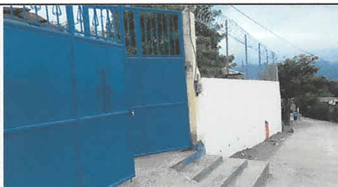
Foto 3: Portón de entrada y pared repellada
