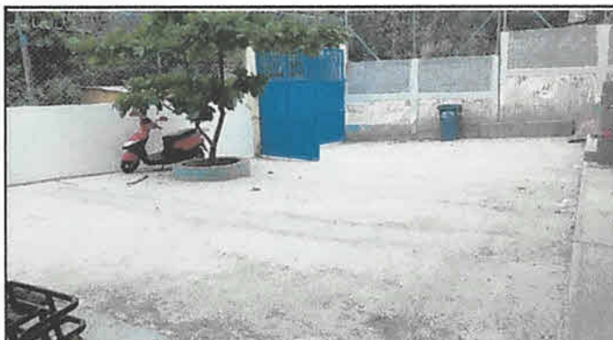
Foto 4: losa y portón
